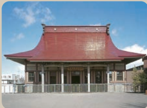
◀ 免震レトロフィットされた 木造建築 『本願寺帯広別院本堂』
