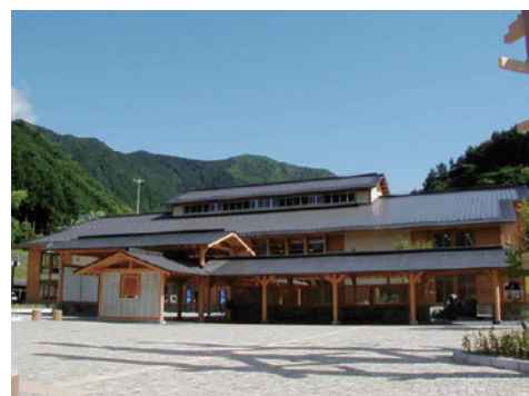
波賀町庁舎:免震装置 FPS
