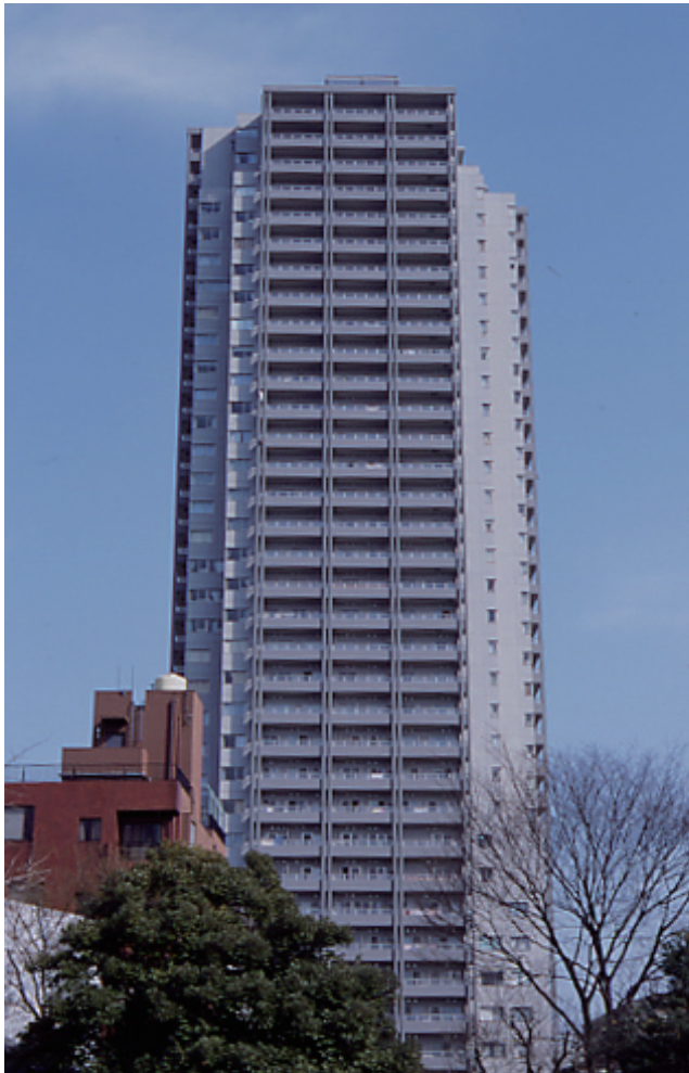
代官山地区第一種市街地再開発事業施設建築物新築工事(工事名称) :制震装置 制震壁(VWD)
